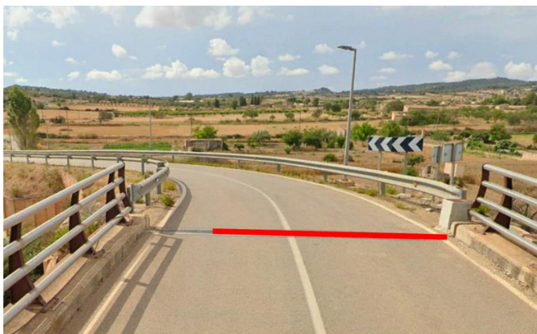
Referencia externa: Junta dilatación puente Coordenadas GPS: 39.560512, 2.976948
